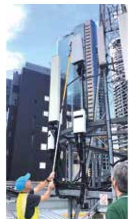
*Mit dem RF Detection Mode (RadMan 2XT) lässt sich schnell und einfach überprüfen, ob die Antenne abgeschaltet ist.*
