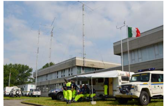
Bild 3: Bei der dichten Positionierung verschiedenster Funkdienste sind Intermodulationen zu erwarten
